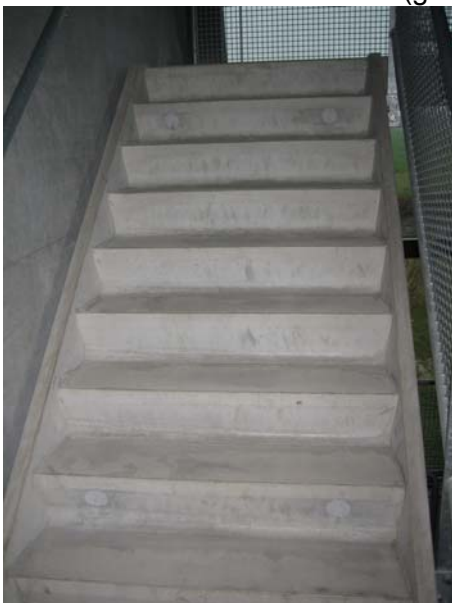
Betonnen trap in het schoolgebouw
