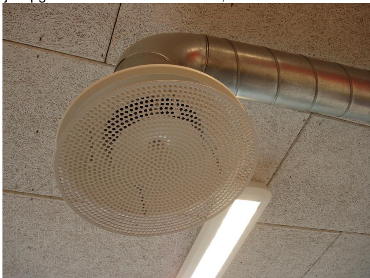
Een buizensysteem zorgt voor de ventilatie van het gebouw
